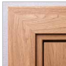
standardowe łączenie opasek pod kątem 45°
