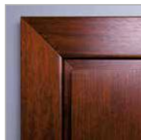
łączenie opasek pod kątem 45°
