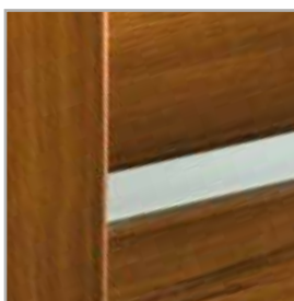
połączenie ramiaka, paneli i szyby
